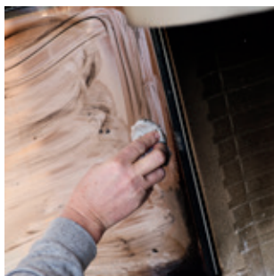
Rengör insidan på glaset med en fuktig trasa doppad i den helt fina askan i kaminen.
