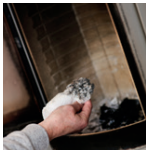
Rens indersiden af glasset med en fugtig klud dyppet i den helt fine aske i ovnen.
